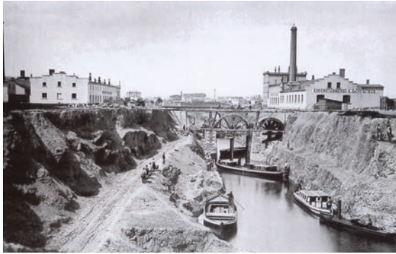
Der Kanal im Bau
