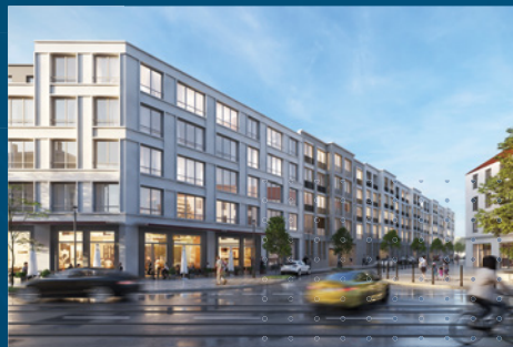
Krystallpalast-Areal Brandenburger Straße in Leipzig
