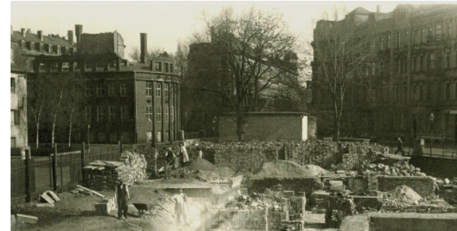
Baustelle im April 1953
