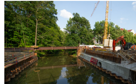
Brückenverschalung mit Auslassneubau
